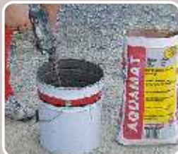
Външните стени на мазетата се намокрят добре и се замазват с **AQUAMAT** от 2 до 4 слоя според степента на водния натиск, който се очаква. Всички слой следва след като предишния изсъхне. Замазването става на слой с дебелина до 1 mm и на височина min 50 cm над земното равнище.
